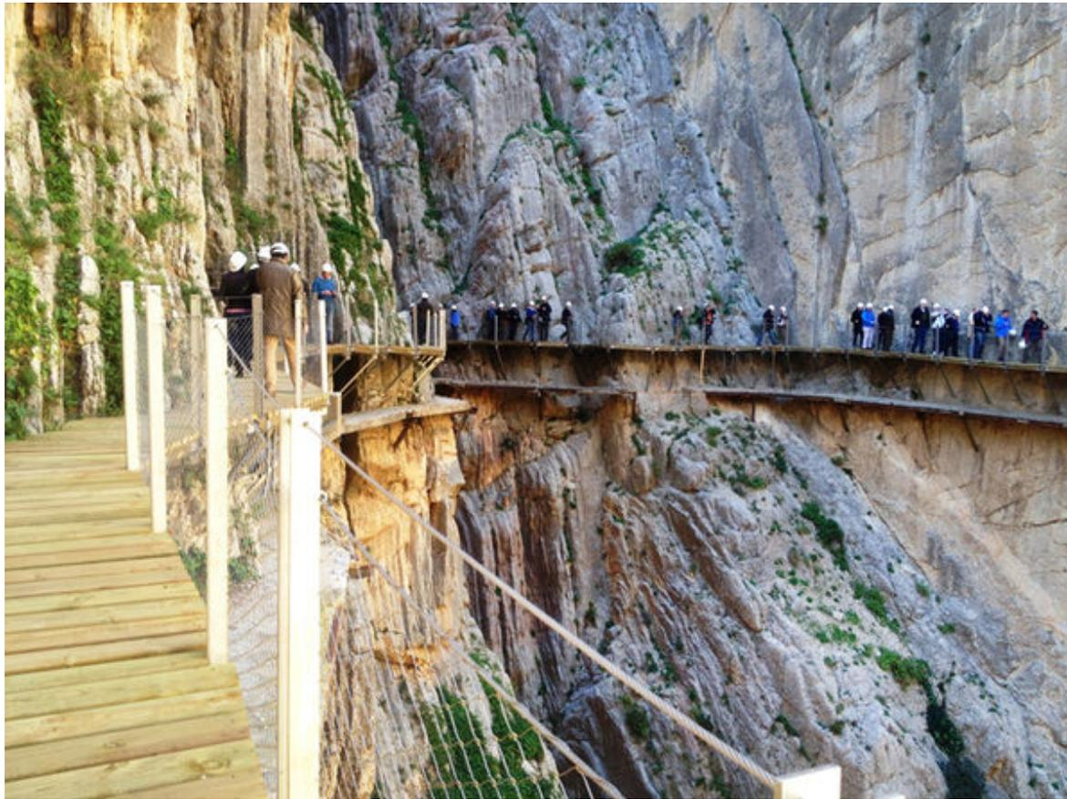
Wie ein gemütlicher Laufsteg wirkt der neue, obere Pfad – im Gegensatz zum darunterliegenden, bei dem bereits größtenteils das Geländer und sogar ganze Betonplatten fehlten
